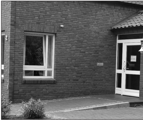
Der neue behindertengerechte Zugang
